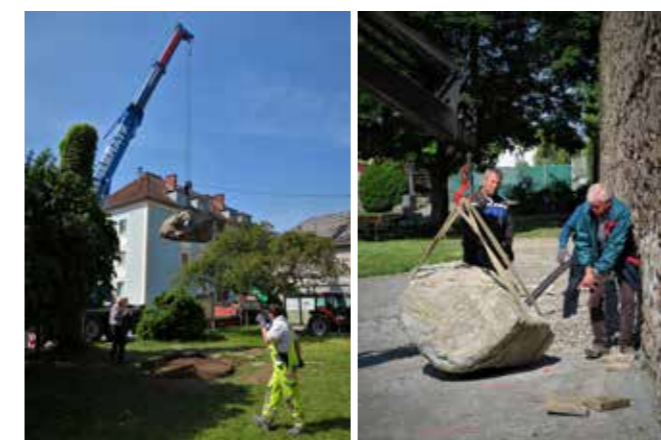
li.: Ein 16-Tonner schwebt! re.: Die zentimetergenaue Positionierung auch von tonnenschweren Granitblöcken ist für einen versierten Bauingenieur eine Selbstverständlichkeit – aber ohne die feinfühlige Bedienung des LKW-Krans auch nicht möglich.
