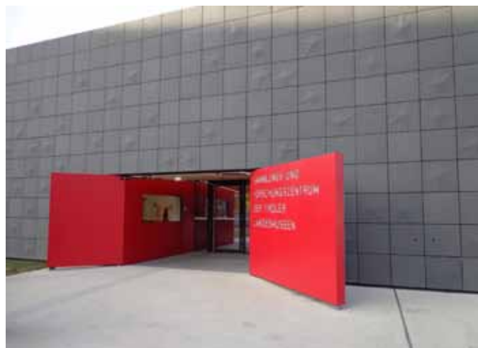
Das neue Sammlungs- und Forschungszentrum (SFZ) der Tiroler Landesmuseen in Tirol (Foto: Verbund Öö. Museen)
