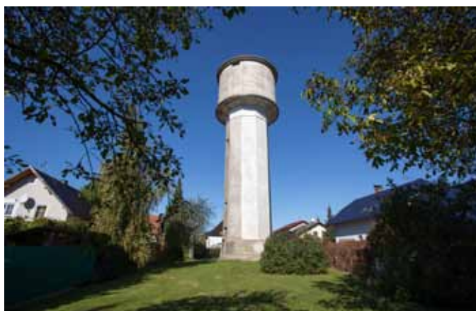
Bauliches Relikt des Kriegsgefangenenlagers ist der Wasserturm, der 1915/16 zur Versorgung der Gefangenen mit Wasser erbaut wurde.
