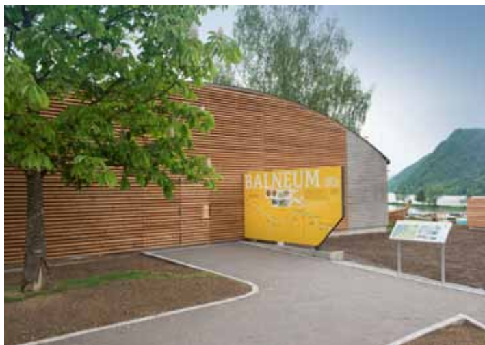
Schutzbau Schlögen (Foto: Pia Odorizzi)
