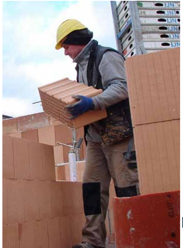
Hausbau: Bauen mit Dämmziegeln und Kleber in Gallneukirchen, 2014 (Foto: Josef Danningner)
