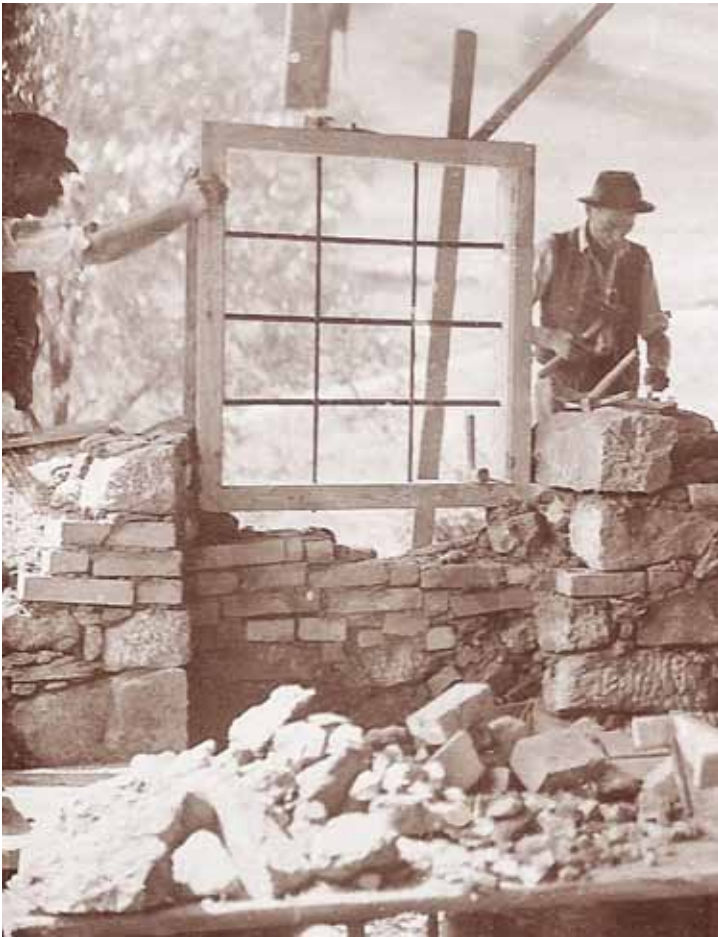
Hausbau: Bauarbeiten am Zülowhaus in Hirschbach, um 1933 (Foto: Privatbesitz)
