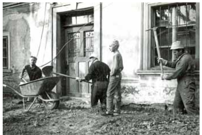
Arbeiten am Fundament (Foto: FLM Furthmühle)
